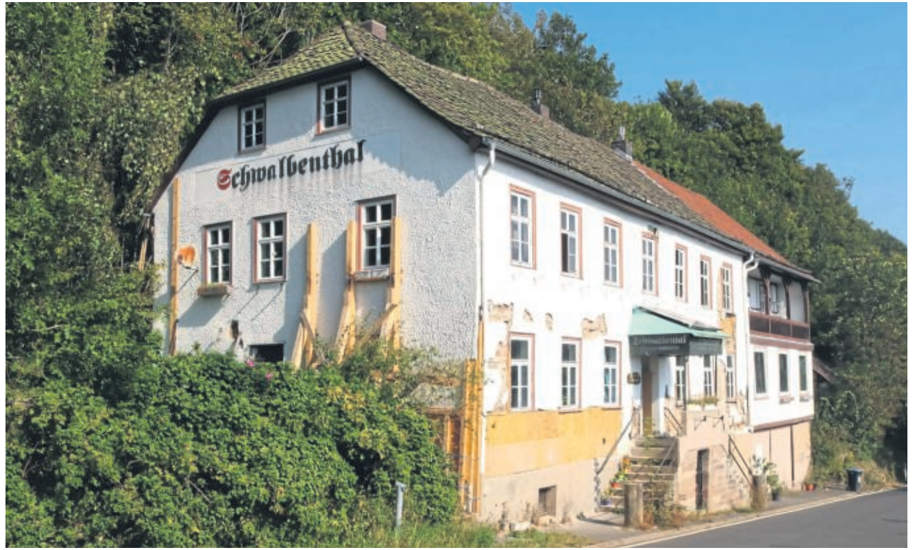
Bewegte Geschichte: Vom Bergamt über die Gaststätte, ein Seminargebäude und einen „Lost Place“ bis hin zur gemeinsamen Vision von Nanosch Beckmann und Jens Herrmann reicht die Geschichte des Hauses Schwalbenthal. Abgestützt wird es gerade von einer Holzvorrichtung.
